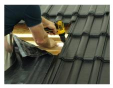
7.1 Для дополнительной опоры, установите обрешетку под проходной элемент кровли и закрепите её между стропилами, расположенными с левой и правой стороны от дымоходной трубы.
