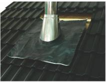
2. Установить проход через кровлю на дымоходную трубу.
