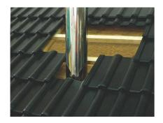
1. Разобрать кровельное покрытие вокруг дымоходной трубы.
