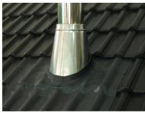
12. Проверьте стыковку кровельного покрытия и герметичность стыков.
