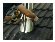
13. Установите уплотнительную манжету от дождя и затяните винт так, чтобы манжета плотно прилегала к дымоходной трубе.
