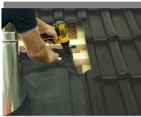
9. Закрепите проходной элемент в верхней части на дополнительную обрешетку тремя кровельными саморезами.
