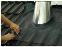
5. Разгладить эластичную часть проходного элемента по форме кровельного покрытия.
