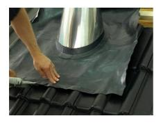
4. Нанести кровельный герметик под проход через кровлю.
