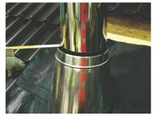
3. Отцентровать проход через кровлю относительно дымоходной трубы.
