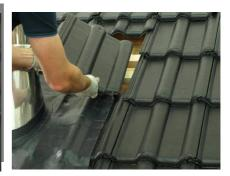
10. Подрежьте кровельное покрытие, чтобы выполнить примыкание к дымовой трубе.
