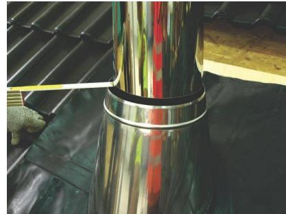
3. Отцентровать проход через кровлю относительно дымоходной трубы.
