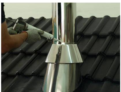
**14. На стык дымоходной трубы с уплотнительной манжетой от дождя нанесите термостойкий герметик.<sup>2</sup>**
