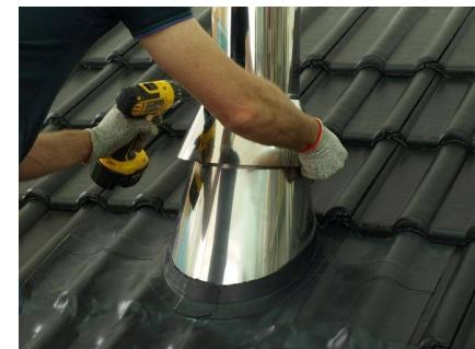
**13. Установите уплотнительную манжету от дождя и затяните винт так, чтобы манжета плотно прилегала к дымоходной трубе.**
