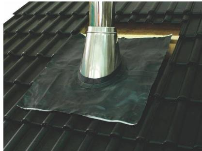
2. Установить проход через кровлю на дымоходную трубу.
