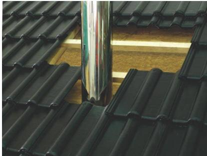
1. Разобрать кровельное покрытие вокруг дымоходной трубы.
