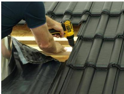
7.1 Для дополнительной опоры, установите обрешетку под проходной элемент кровли и закрепите её между стропилами, расположенными с левой и правой стороны от дымоходной трубы.
