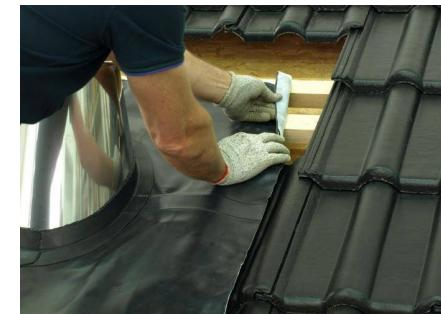
8.1 Сформируйте на боковых и верхних краях проходного элемента кровли дренажные барьеры согласно рекомендациям производителя кровельного покрытия.<sup>1</sup>
