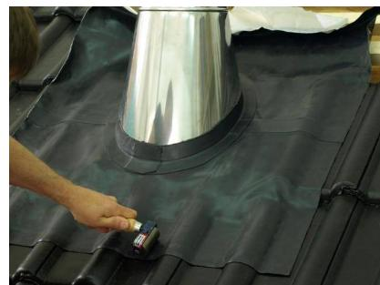
6. При помощи валика окончательно разгладьте эластичную часть проходного элемента.
