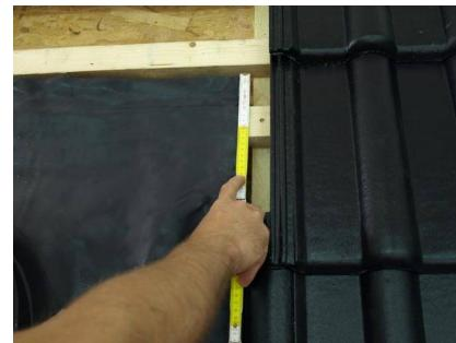
7.2 Обрешетка должна быть закреплена на 5 см ниже верхнего края проходного элемента кровли.
